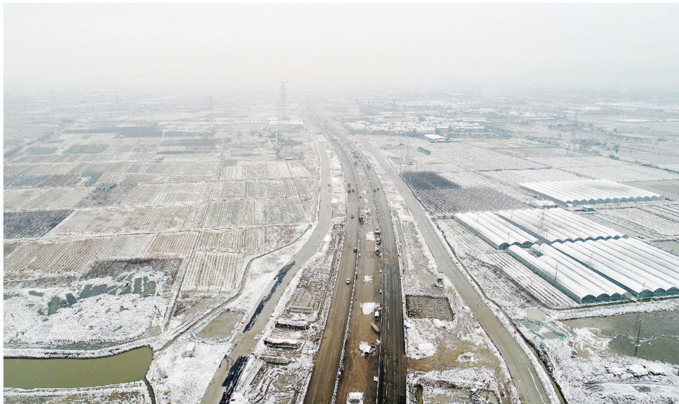
宁波机场快速路南延南段工程施工 IV 标段 (宁波公司承建)
