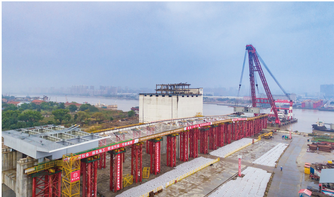
宁波中兴大桥（400米单跨矮塔斜拉桥）主桥上部结构安装（总承包公司承建）
