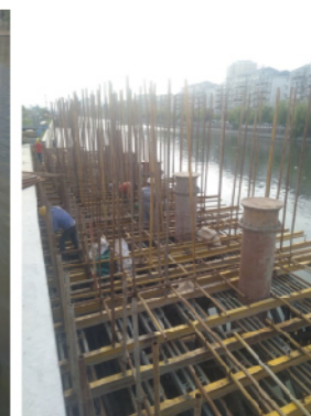
端横梁支架施工
