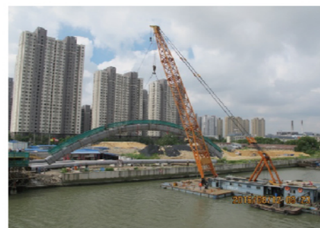
钢管拱吊装施工
