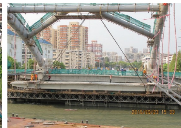
预制中横梁吊装施工
