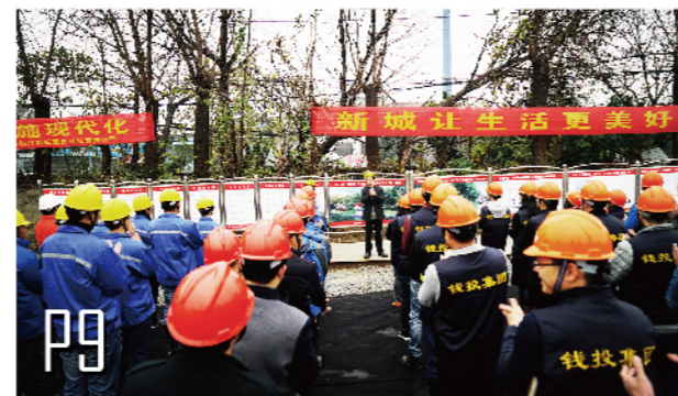
2016年12月20日，杭州沿江大道地下综合管廊项目开工。
