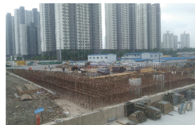
箱梁满堂脚手架施工
