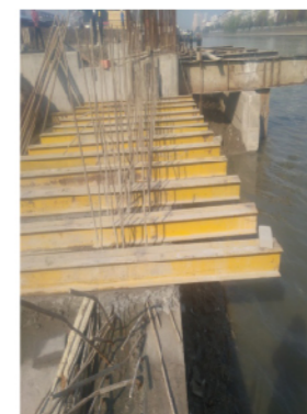
端横梁支架施工
