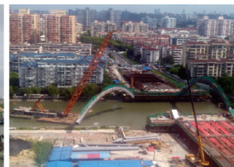
钢管拱吊装施工
