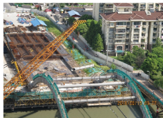
斜风撑吊装施工
