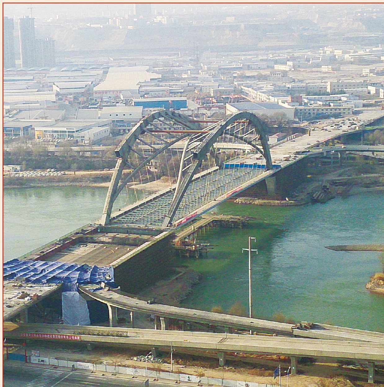
宏润投资并总承包施工兰州深安黄河大桥工程
